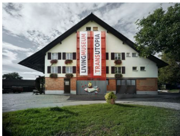
Abbildung 3: Gutsbetrieb, Klinik Wil
