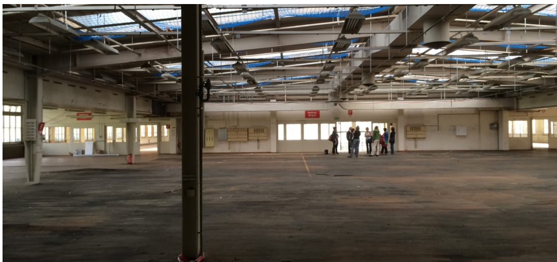
Abb. 2: Halle Freyraum Wangen
